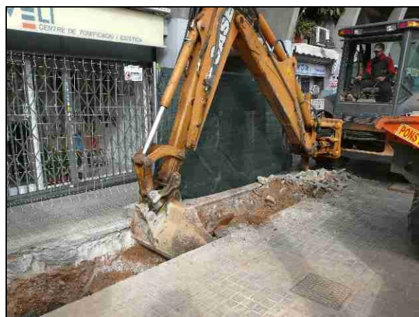
FOTO 6. Excavació de forma mecànica de la rasa 1 en el tram de la vorera. Des de l'est.
