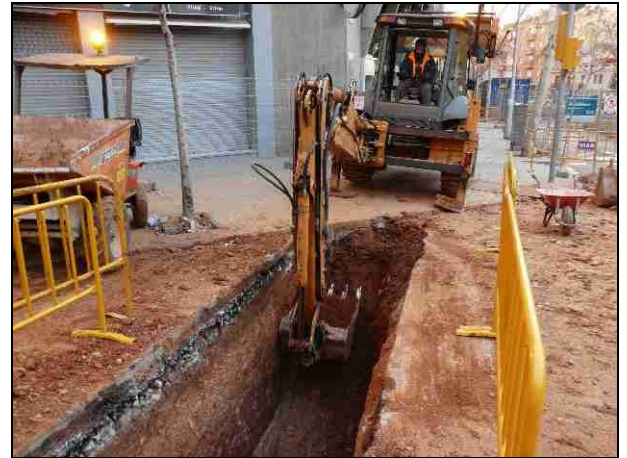
FOTO 2. Excavació de forma mecànica de la rasa 1.
