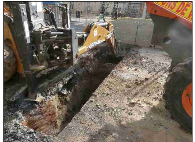
FOTO 4. Excavació de forma mecànica de la rasa 2 i embornal 1. Des de l'oest.
