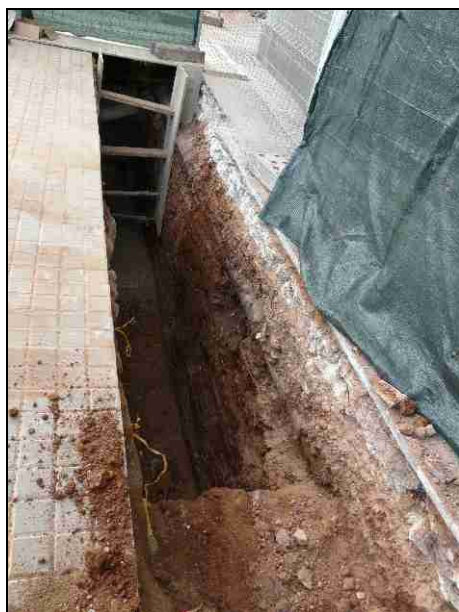
FOTO 7. Vista del tram final de la rasa 1 discorrent per la vorera. Des del nord-est.
